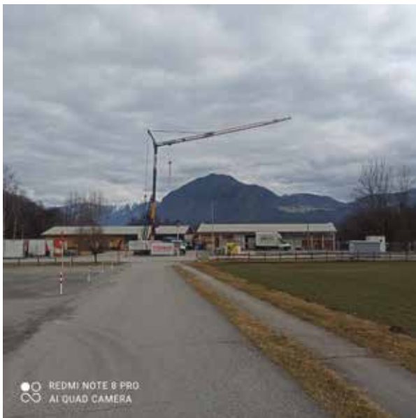
Die Umbauarbeiten am Landeplatz in Greifenburg schreiten zügig voran.
